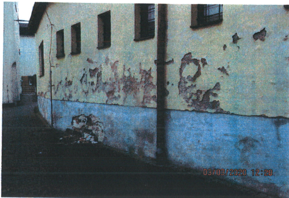
Obr. 9 - Degradace zdiva soklu
