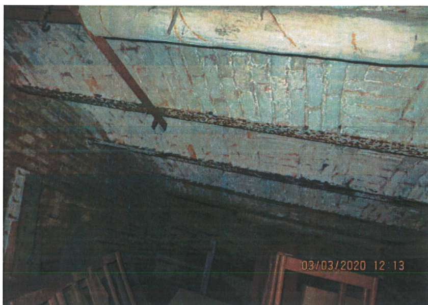
Obr. 4 - ocelové nosníky segmentových kleneb, postižené korozí
