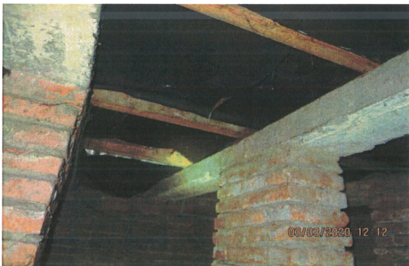
Obr. 5 - nosný systém podlahy jeviště-desky, trámy, betonové průvlakky
