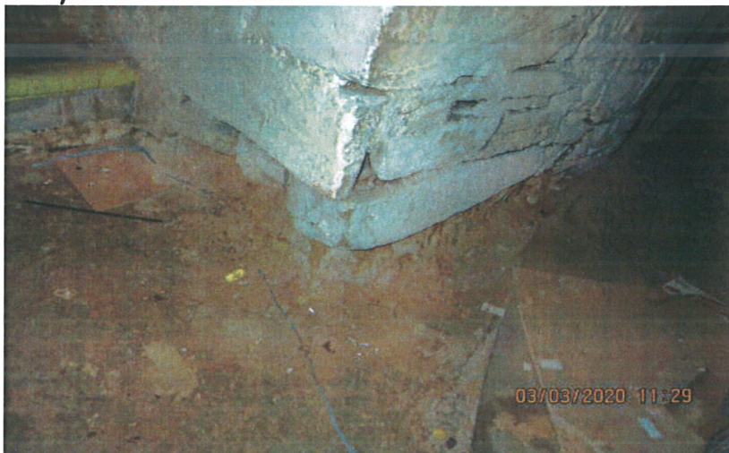
Obr. 1 - Pata pilíře bez základu
