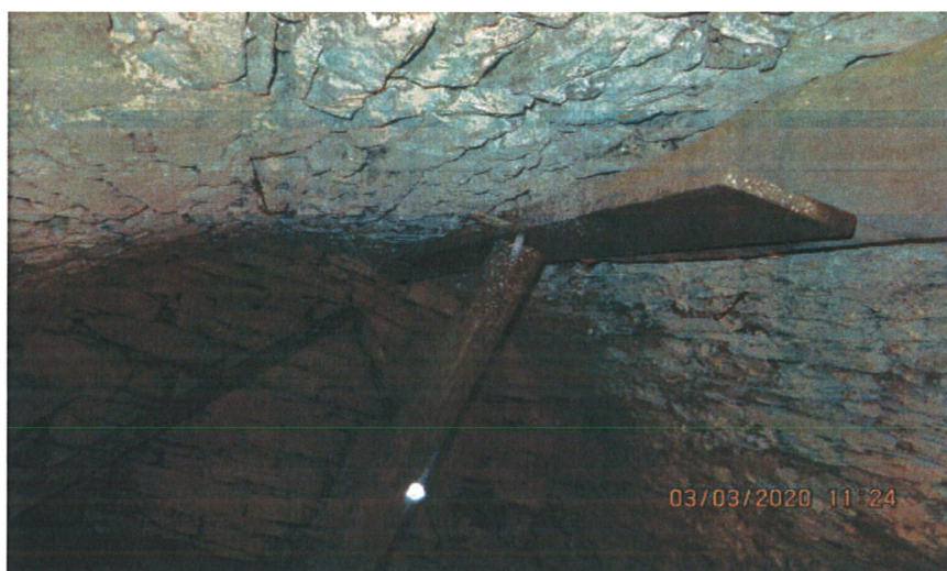
Obr. 2 - montážní podepření vrcholu klenby
